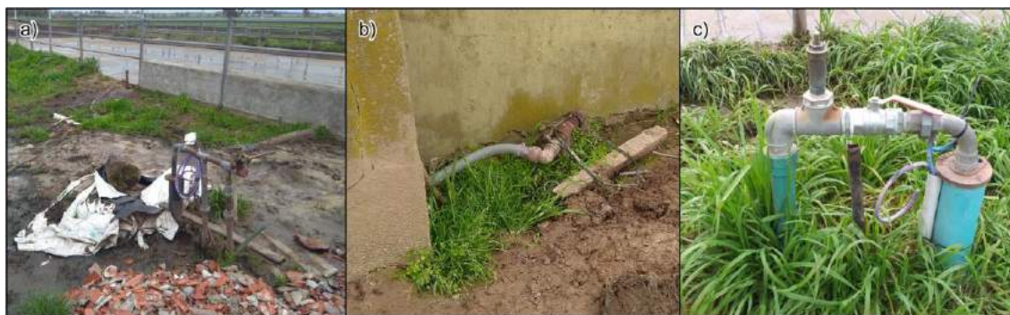
Figura 4. Pozos dirigidos hacia el acuífero semiconfinado en los predios tamberos del área de estudio.
