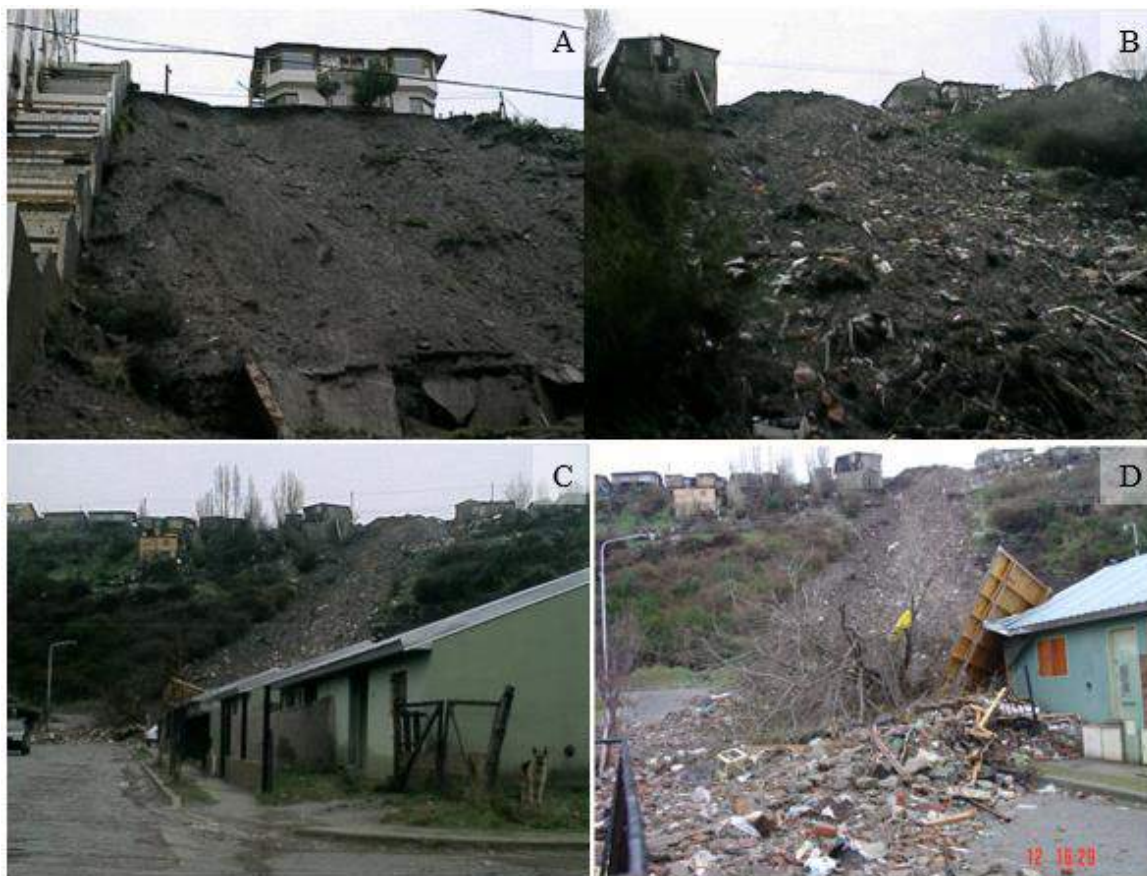
Figura 6 A, B, C y D. Deslizamientos en la barda del Ñireco ocasionados por fuertes precipitaciones en el año 2004. Fuente: Municipalidad de San Carlos de Bariloche; Pereyra & Helms, 2006.
