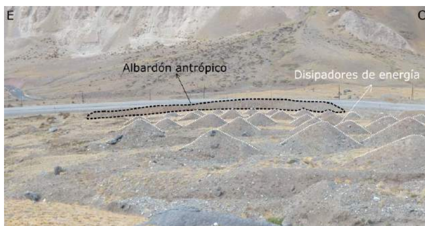
Figura 3. Vista desde la quebrada Agua Salada en dirección hacia el sur. Se observan albardones antrópicos y disipadores de energía construidos en el abanico occidental en el año 2009. Fotografía tomada en abril de 2019.
