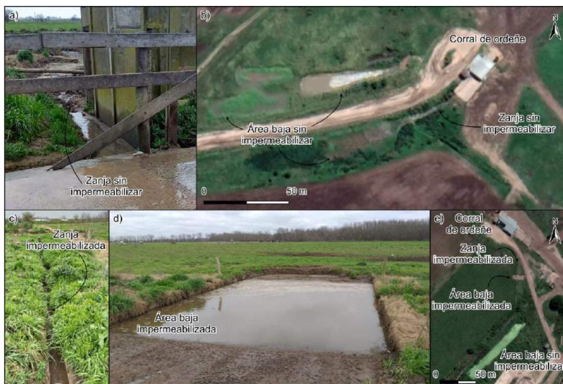
Figura 3. a. Zanja para evacuar agua de lavado sin impermeabilización. b. Tambo de ordeño donde se puede apreciar el zanjeo para conducir el agua del lavado a sector bajo sin impermeabilización. c. Zanja para evacuar agua de lavado con impermeabilización de hormigón. d. Bajo excavado e impermeabilizado con hormigón para almacenar momentáneamente el agua de lavado. e. Tambo de ordeño donde se puede apreciar el zanjeo para conducir el agua del lavado a sector bajo impermeabilizado y posteriormente por rebalse a un área más baja sin impermeabilización.
