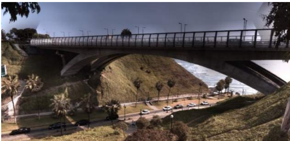
Figura 5. Puente Villena Rey.
