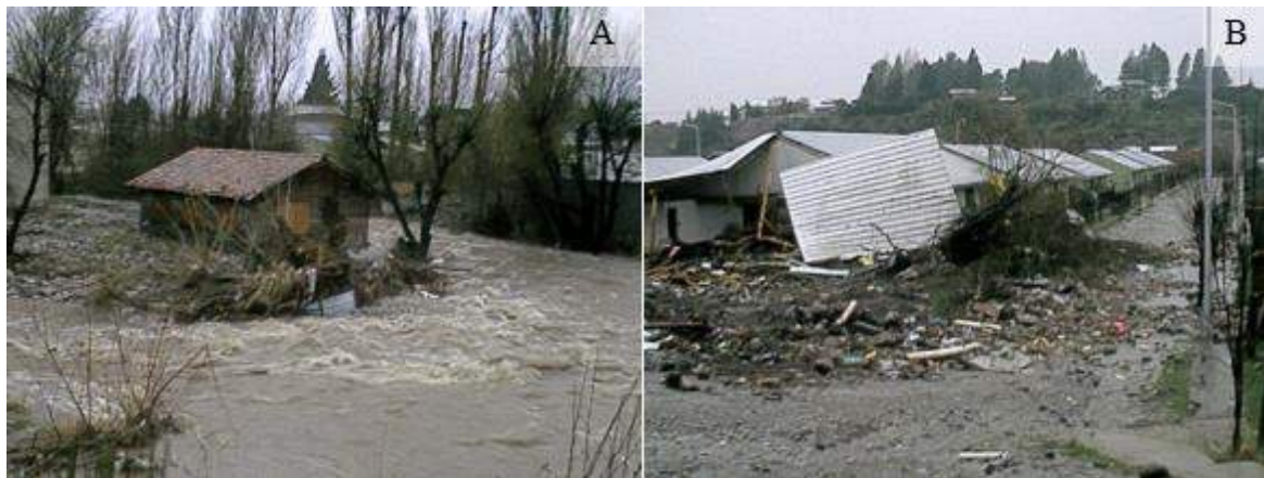
Figura 5 A y B. Anegamiento de hogares y calles ocasionada por la crecida extraordinaria del A° Ñireco en el año 2004. Fuente: Municipalidad de San Carlos de Bariloche.
